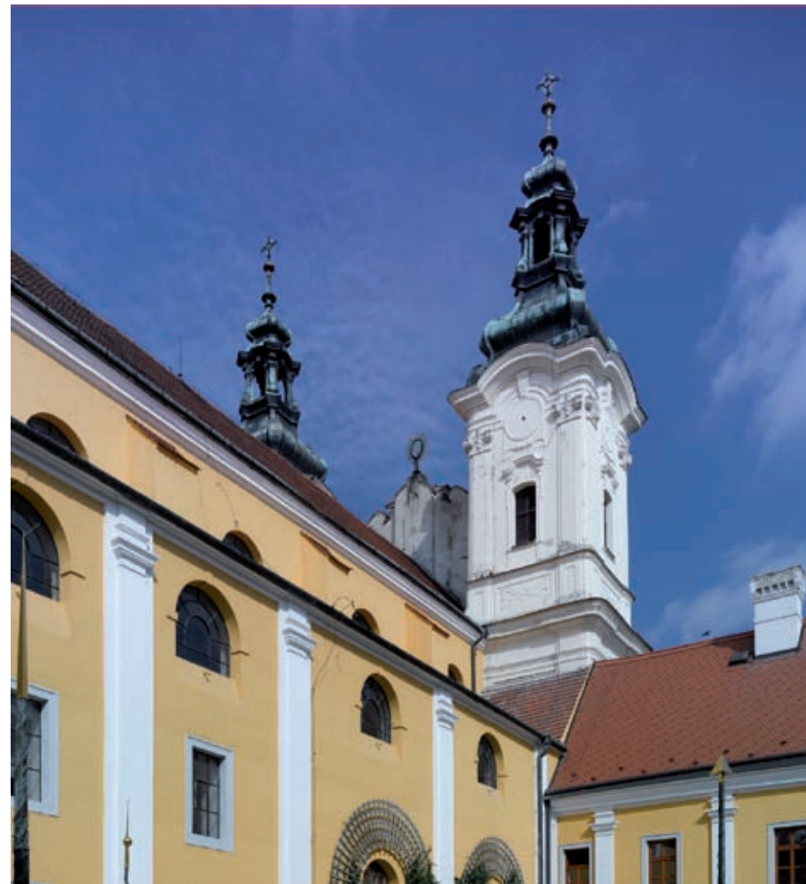
Věž kostela sv. Františka Xaverského v Uherském Hradišti
